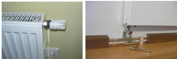
Horizontalaus paskirstymo šildymo sistema butuose su efektyviais naujo tipo radiatoriais ir termoreguliatoriais.
